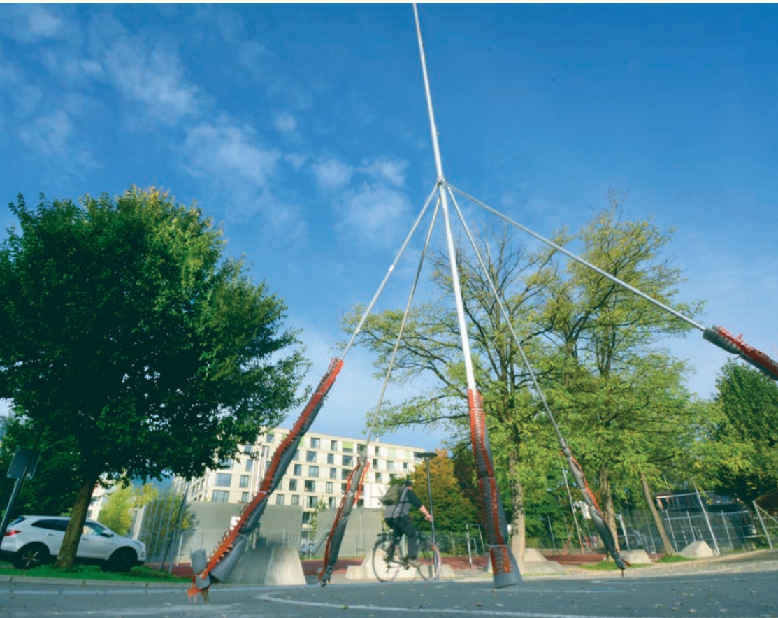
Sie steht für den baldigen Baubeginn: Eine der vier Profilstangen für das neue Schulhaus Allmend.
