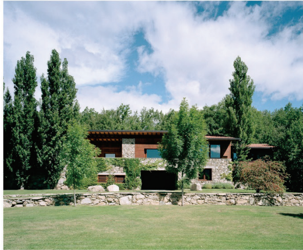
Ingla House Travesseres (E) - Santi Vives Arquitectura 1998
