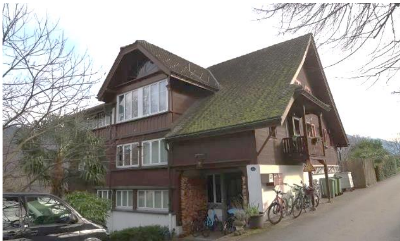
Abbildung 35 Aussenansicht Wohnhaus Reblaubenweg 3
