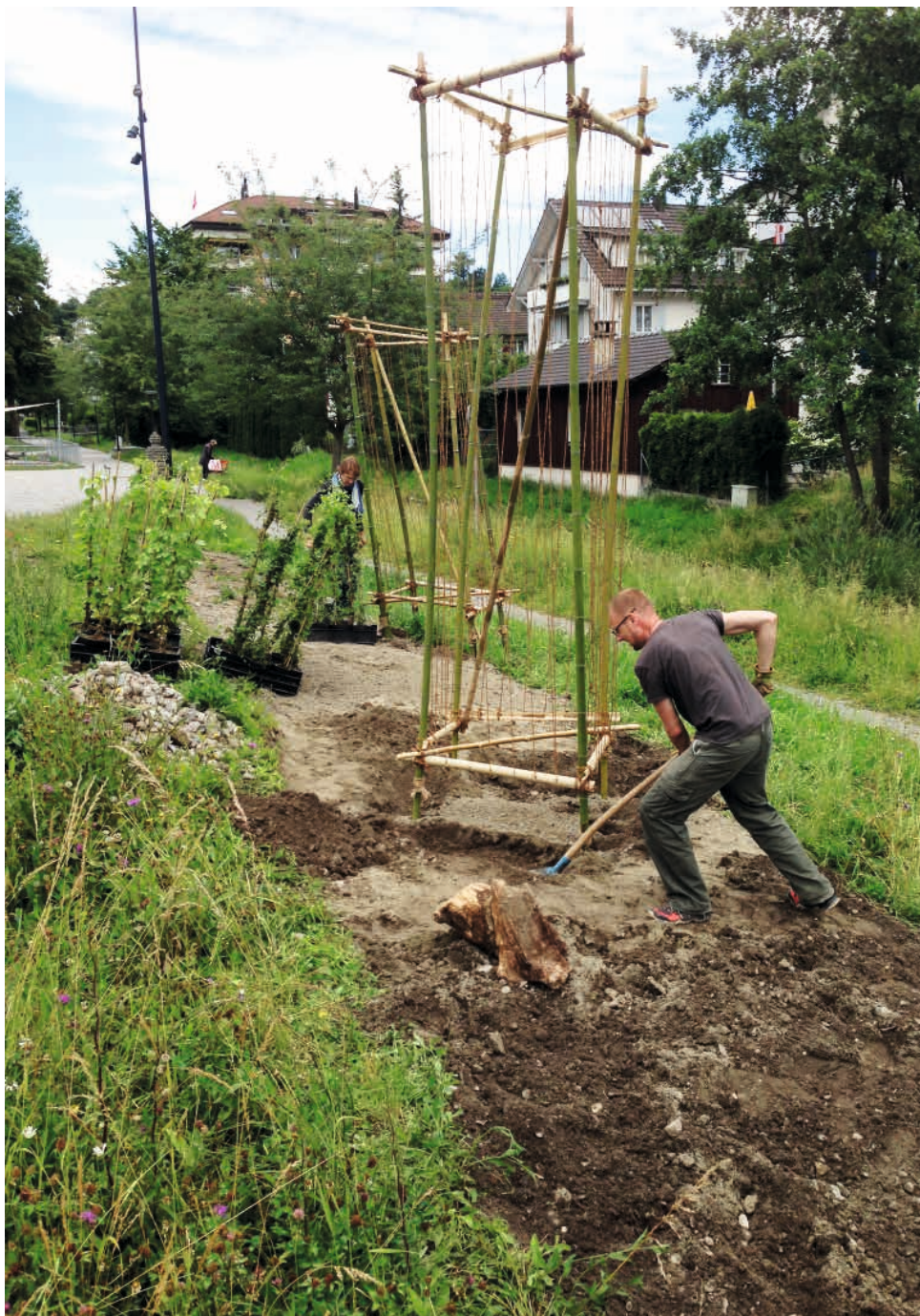
Hier entsteht entlang des Dorfbachs die Biodiversitäts-Modellfläche im Horwer Zentrum.
