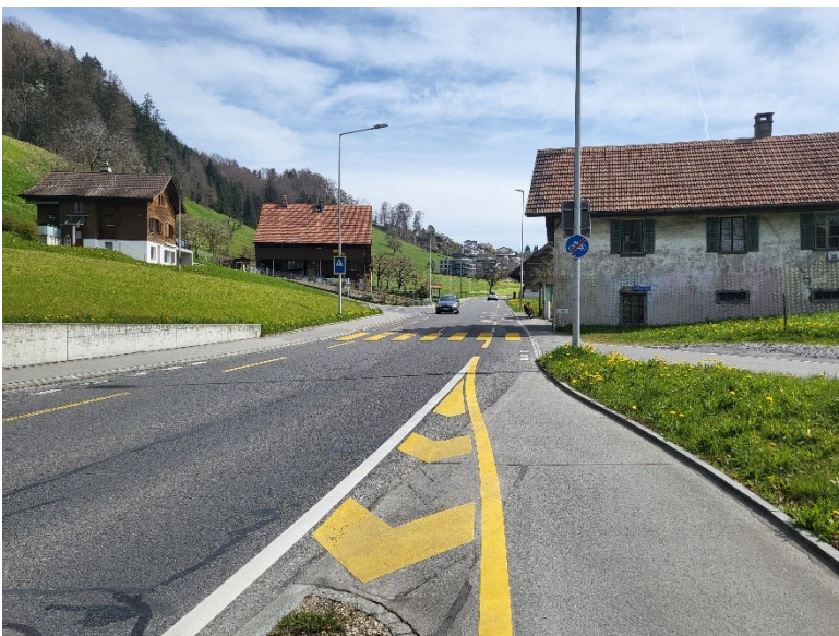
Abbildung 2 Einmündung des Veloweges auf die Kastanienbaumstrasse an enger Stelle
