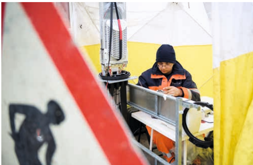
Ein Monteur verrichtet Arbeiten bei der Verlegung eines Glasfaserkabels.
