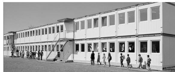
3. **Holzelementbau**, ökologische Ausführung. Wände aussen Holz, innen Fermacell, Fenster in Holz, gute Dämmung. 30 Klassenräume à 64 m2. Optimierte Variante für geforderten Raumbedarf. Standort Schulhausstrasse Horw, Parzelle 2018 **Gesamtkosten 10 Jahre Nutzungsdauer 3'100'000 CHF**
