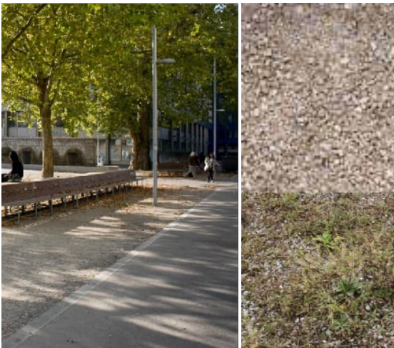
Chaussierung (links u. oben), Schotterrassen (unten)
