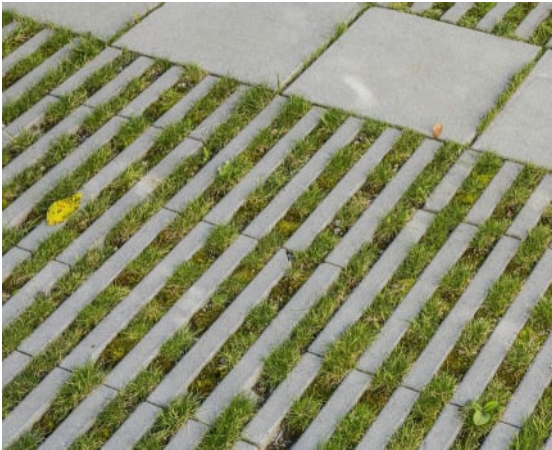
Rasenliner / Rasengittersteine unter Stellflächen
