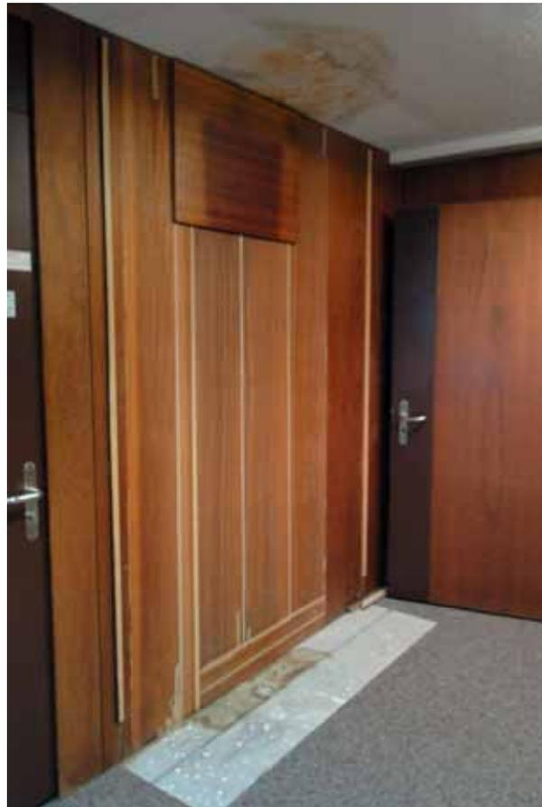
Durch eines der undichten Flachdächer ist Wasser eingedrungen. Die Schrankwand musste entfernt werden.
