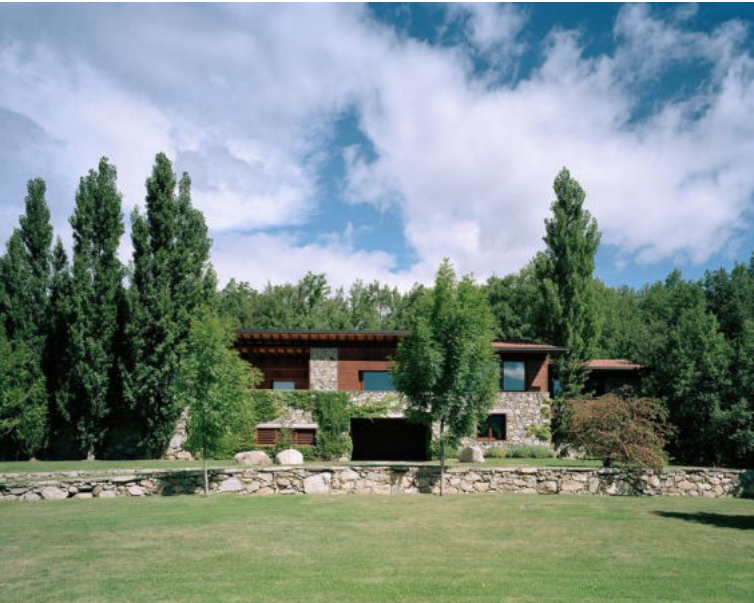
Ingla House Travesseres (E) Santi Vives Arquitectura 1998
