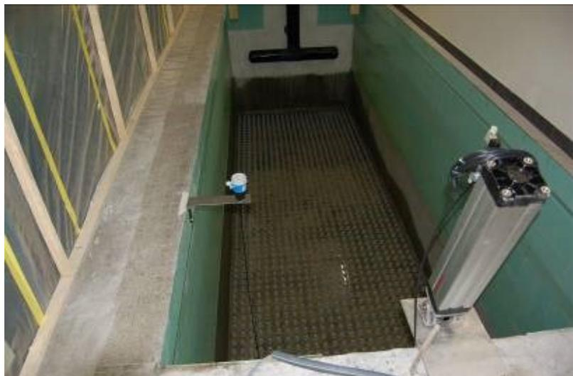
Abbildung 6: Blick in ein leeres Filterbecken (mit Bodendüsen), welches 2007 minimal saniert wurde.
