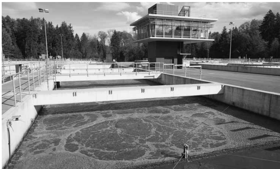
Biologiebecken und Tower ARA Region Luzern
