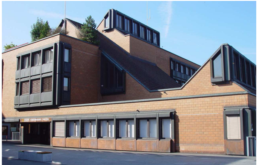
Das Horwer Gemeindehaus am Gemeindehausplatz 1. Um das Gemeindehaus ist genügend Platz für einen Apéro im Freien abzuhalten. Bei schlechter Witterung steht das Foyer zur Verfügung (ist mit dem Zivilstandsbeamten rechtzeitig abzusprechen).
