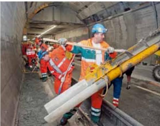
Im Sonnenberg-Tunnel werden die neuen Bankette betoniert. Foto Priska Ketterer
