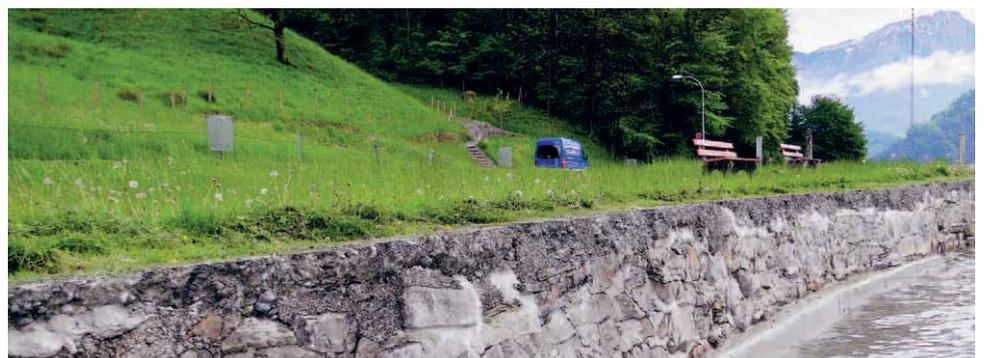
*Blick auf die sanierte Mauer, die neue Foundation und die geflickten Löcher.*
